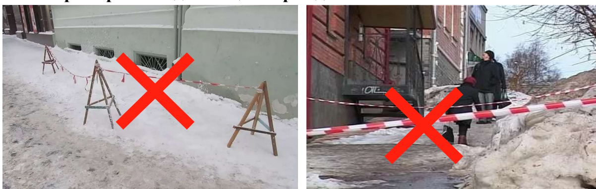
Не обеспечен безопасный проход граждан.
